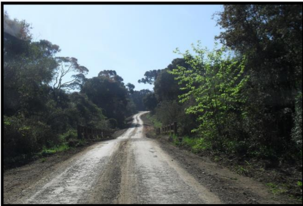
FIGURA 2: Estrada de acesso a Comunidade Bituva dos Machados
