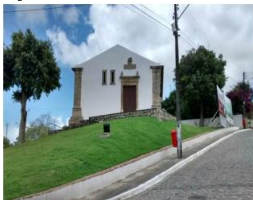
Figura 8: Casa da Pólvora
